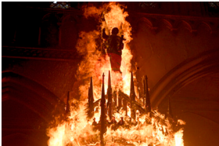
Iglesia de San Francisco de Borja arde durante manifestaciones en Santiago de Chile.
