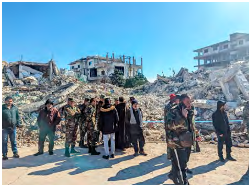
Delegación de ACN revisa las edificaciones en Lattakia, Siria, para verificar daños tras el terremoto.
