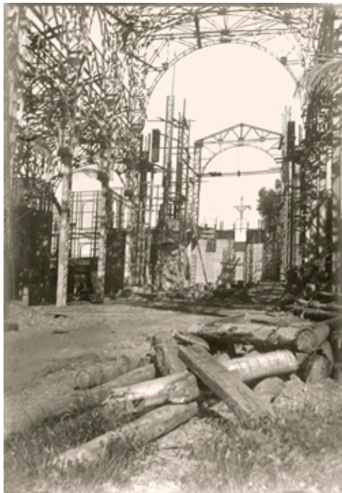
En 1912, Víctor Auclair retoma el proyecto comenzado por Provasoli y ejecuta una estructura de acero que será revestida en hormigón.
