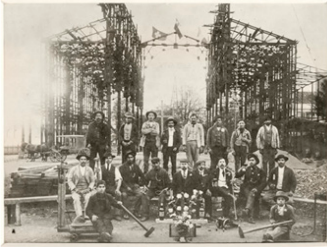
En 1912, Víctor Auclair retoma el proyecto comenzado por Provasoli y ejecuta una estructura de acero que será revestida en hormigón.
